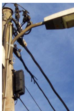
Exempel på skarvboxar med kontaktfält
